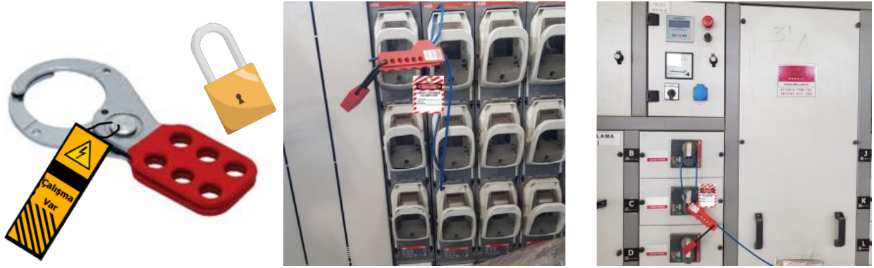
Şekil 6. EKED aparatları ile dikey sigortalı yük ayırıcıda ve termik manyetik şalterde yapılan saha uygulaması
